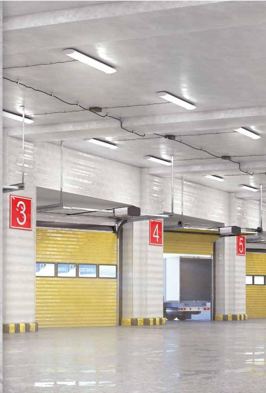
Robuster linienförmiger Wärmemelder
